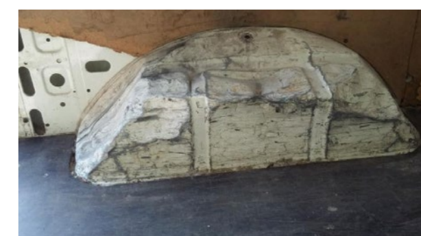
Deformări interne: Perforări, tăieturi, deformări care nu pot fi remediate prin reparații economice. Denaturare și depuneri care nu pot corectate (pulbere, vopsea etc.) (Pasaj de roată irecuperabil dacă durată de reparare < 3 h)
